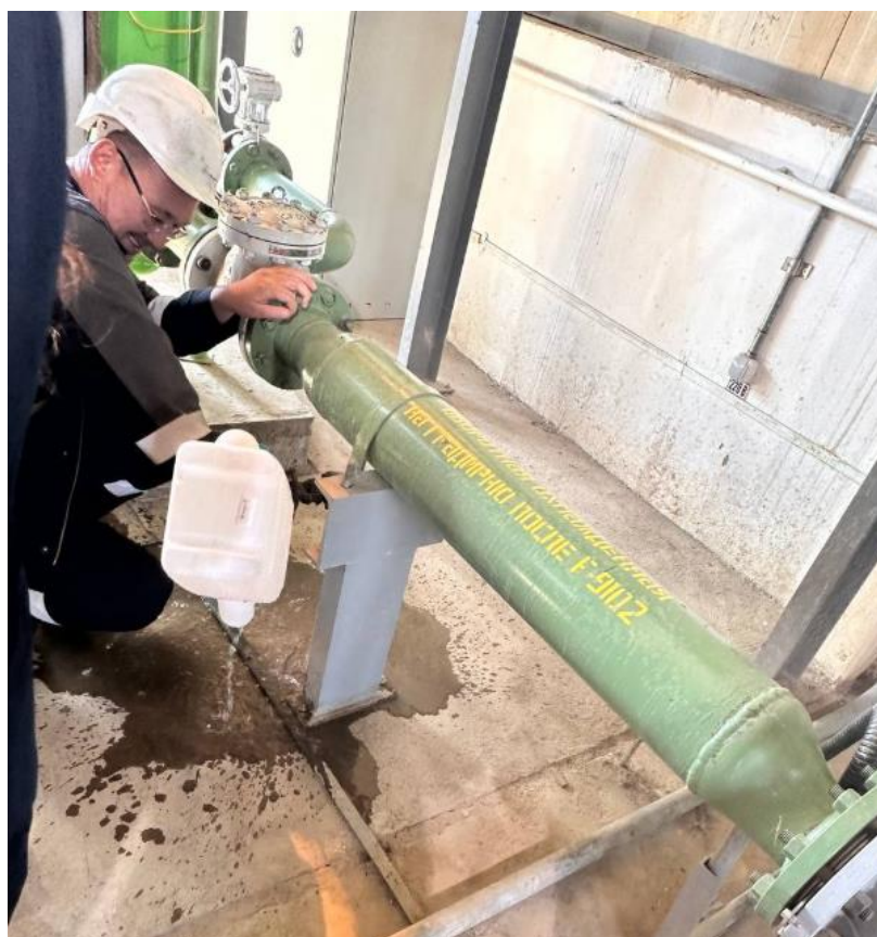
Рисунок 3 – Отбор проб с БОВ-2 системы №2
